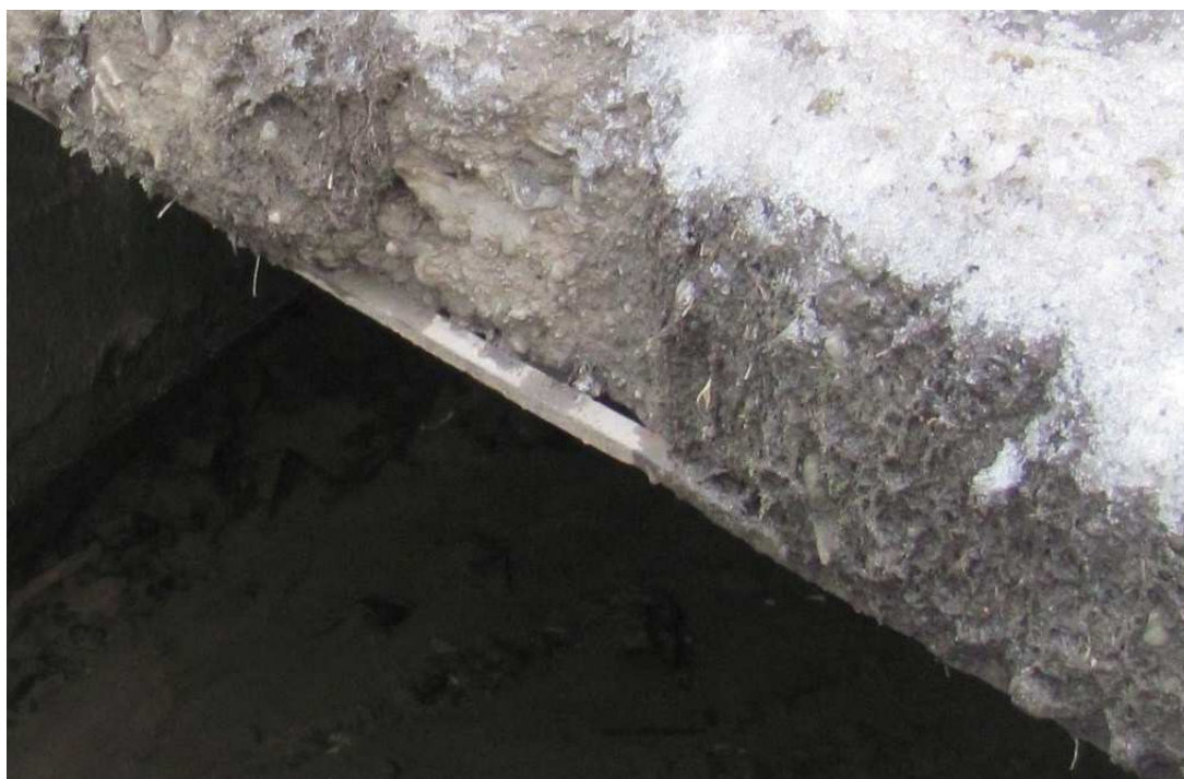
Fot. 1. Ubytki betonu, korozja stali zbrojeniowej w płycie głównej (pomostu)
