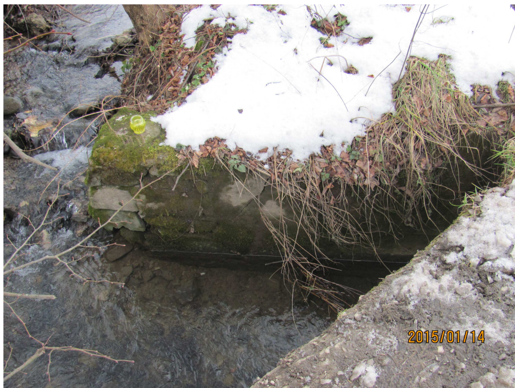
Fot. 3. Ubytki materiału oraz pęknięcia w skrzydełkach.
