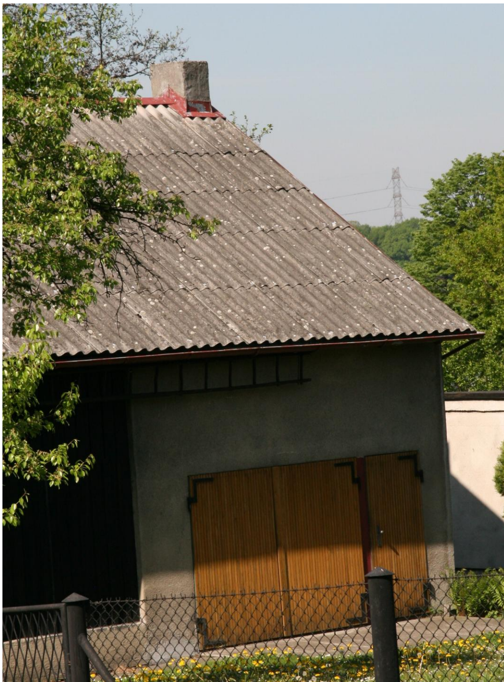
Rysunek 3 Dach pokryty płytami azbestowymi falistymi
