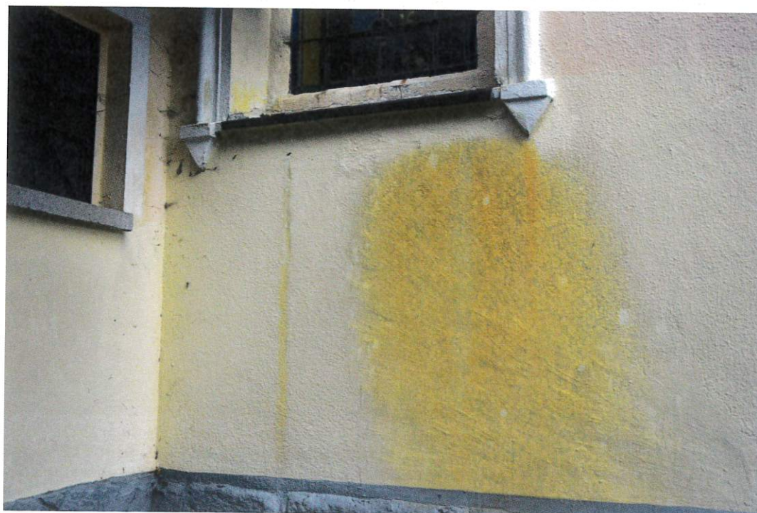
Fot. nr 9 Fot. nr 10 Kaplica Matki Boskiej Szkaplerznej w Kamesznicy. Widoczny zły stan tynków spowodowany zawilgoceniem i wadliwą technologią wykonania. Cokół kamienny dzwonnicy zabrudzony, z cementowymi uzupełnieniami spoin.
