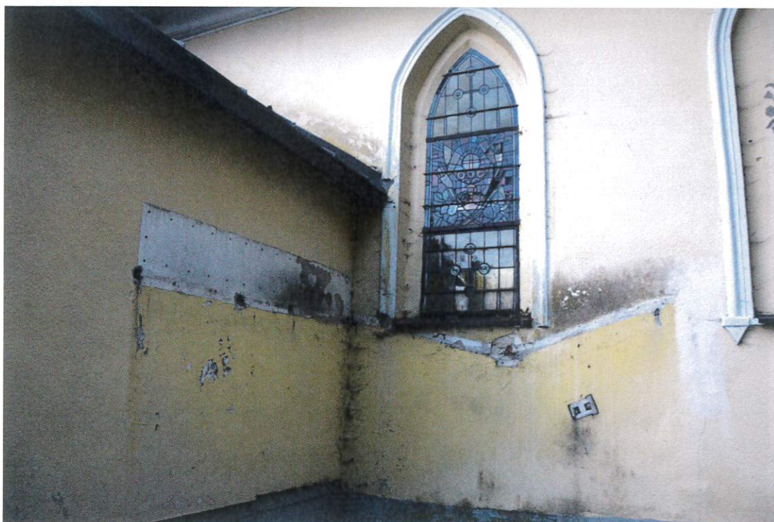
Fot. nr 17 Fot. nr 18 Kaplica Matki Boskiej Szkaplerznej w Kamesznicy. Widoczny zły stan tynków spowodowany zawilgoceniem i wadliwą technologią wykonania; pęknięcia, rozwarstwienia zacierów i tynków cementowych, objawy korozji biologicznej.
