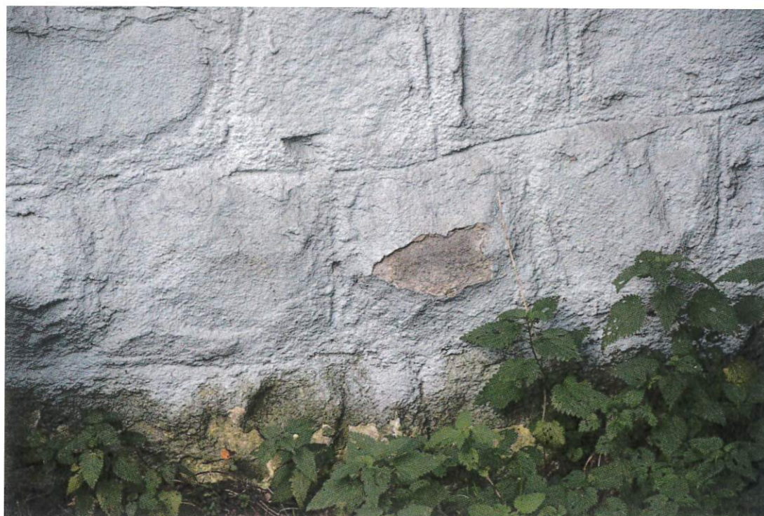
Fot. nr 19 Fot. nr 20 Kaplica Matki Boskiej Szkaplerznej w Kamesznicy. Widoczny zły stan tynków i kamienia; pęknięcia, odspojenia, rozwarstwienia zacierek i tynków cementowych, objawy korozji biologicznej, przemalowanie farbą elewacyjną cokołu kamiennego, rozwarstwianie się i osypywanie piaskowca.
