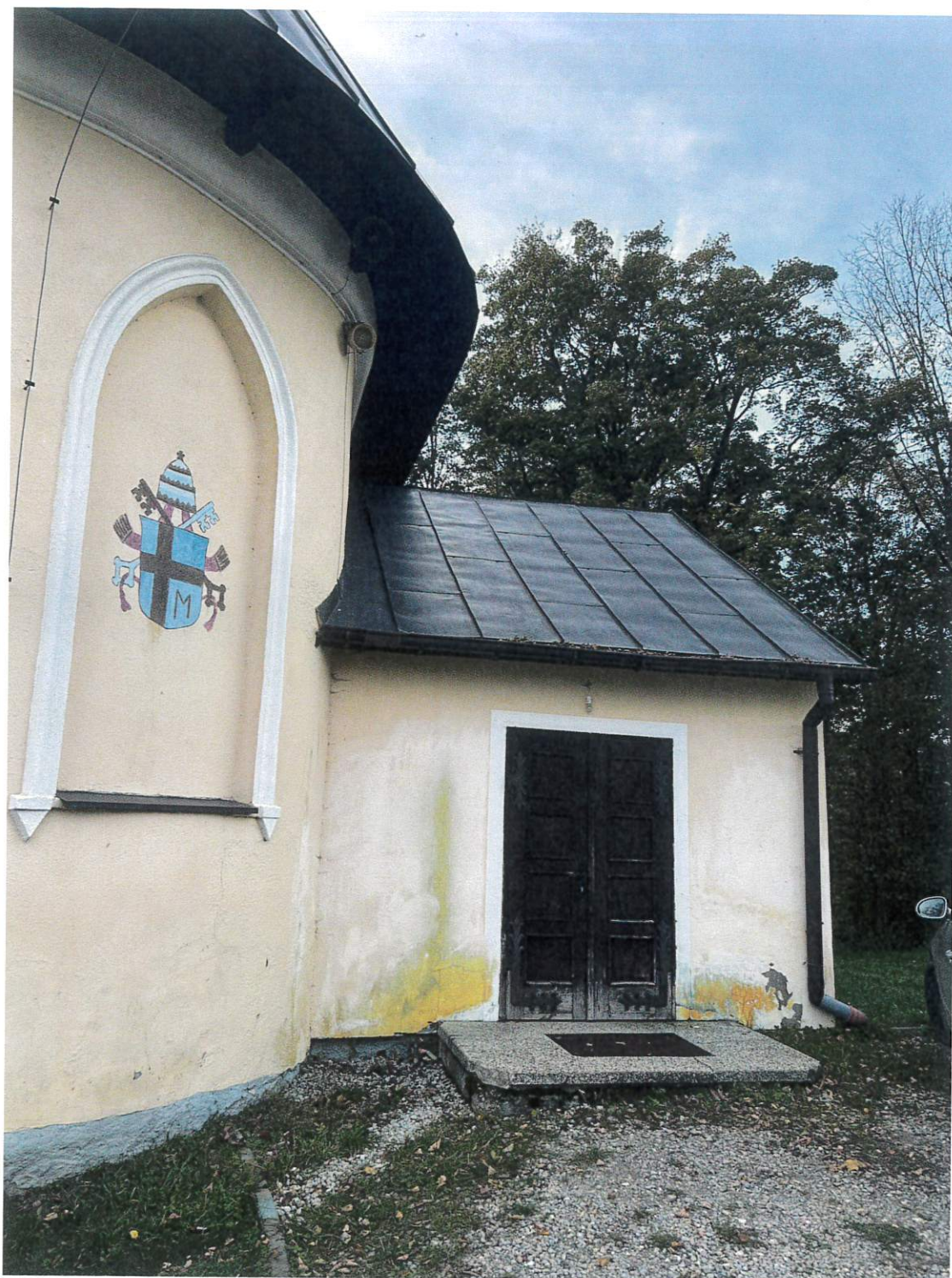
Fot. nr 7 Kaplica Matki Boskiej Szkaplerznej w Kamesznicy, zakrystia od strony południowej. Widoczny zły stan tynków spowodowany zawilgoceniem i wadliwą technologią wykonania – widoczne odspojenia, spękania, korozja biologiczna, przetarcia i złuszczenia do spodnich warstw przemalowań.
