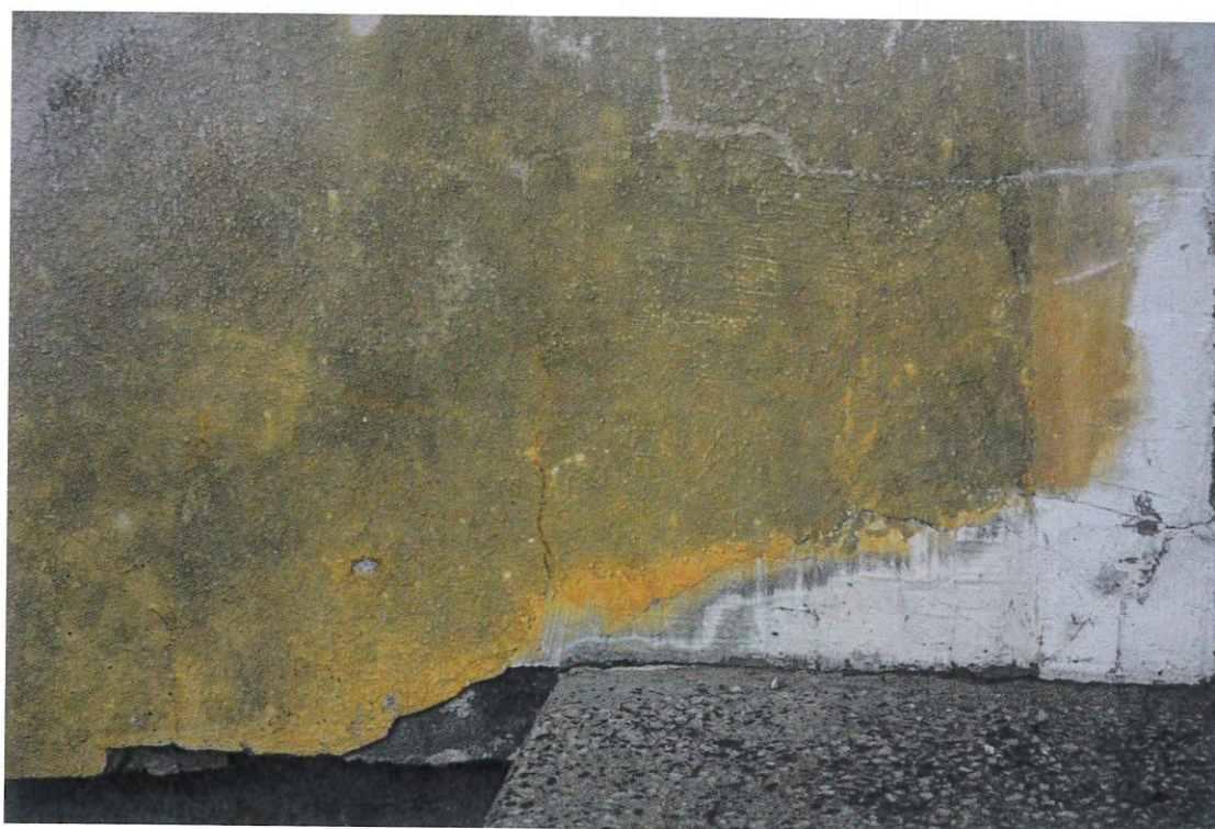
Fot. nr 15 Fot. nr 16 Kaplica Matki Boskiej Szkaplerznej w Kamesznicy. Widoczny zły stan tynków spowodowany zawilgoceniem i wadliwą technologią wykonania. Widoczne rozwarstwienia zacierek i tynków cementowych.
