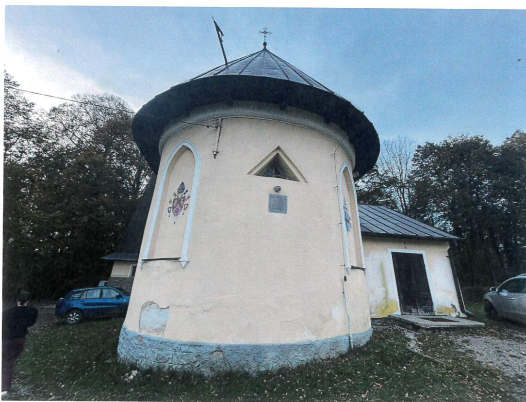
Fot. nr 3 Fot. nr 4 Kaplica Matki Boskiej Szkaplerznej w Kamesznicy, strona wschodnia, prezbiterium. Widoczny zły stan tynków spowodowany zawilgoceniem i wadliwą technologią wykonania. Cokół kamienny przemalowany farbą, która złuszcza się, a kamień rozwarstwia i pudruje.
