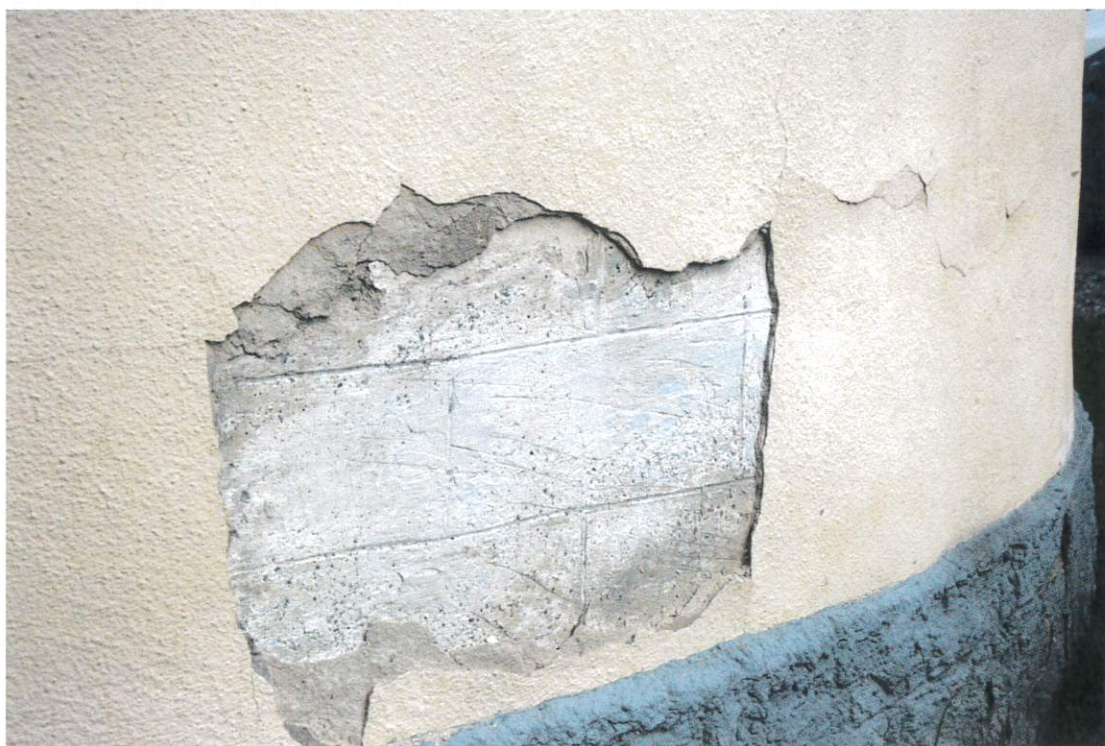
Fot. nr 11 Fot. nr 12 Kaplica Matki Boskiej Szkaplerznej w Kamesznicy. Widoczny zły stan tynków spowodowany zawilgoceniem i wadliwą technologią wykonania.
