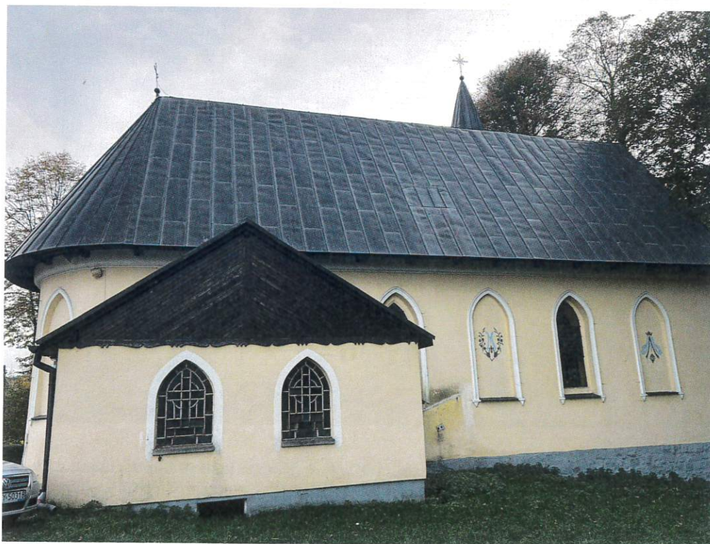
Fot. nr 5Fot. nr 6 Kaplica Matki Boskiej Szkaplerznej w Kamesznicy, strona południowa. Widoczny zły stan tynków spowodowany zawilgoceniem i wadliwą technologią wykonania. Cokół kamienny przemalowany farbą.
