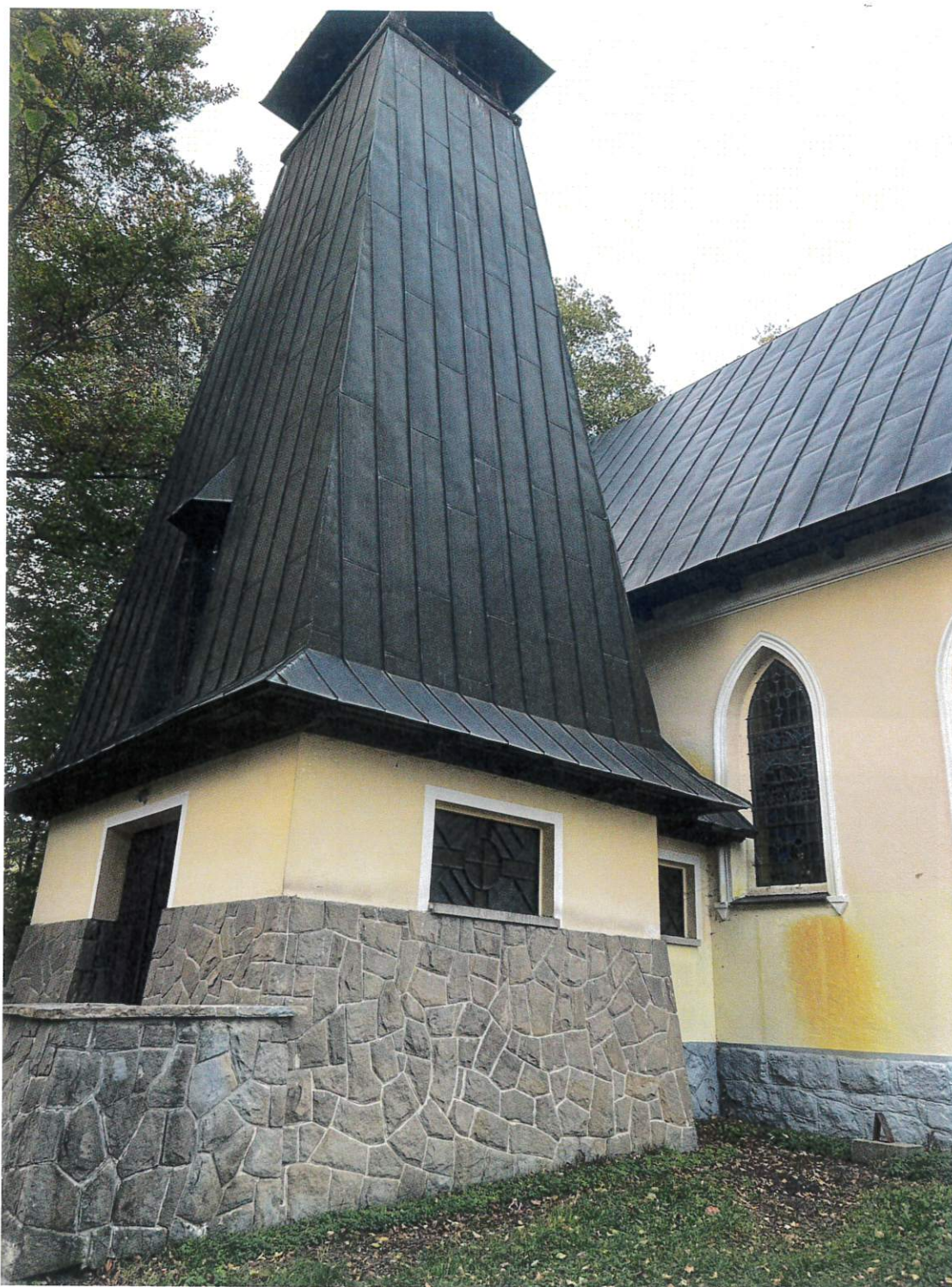
Fot. nr 2 Kaplica Matki Boskiej Szkaplerznej w Kamesznicy, dzwonnica. Widoczny pokryty czarną patyną kamień i naprawy cementowe spoin.
