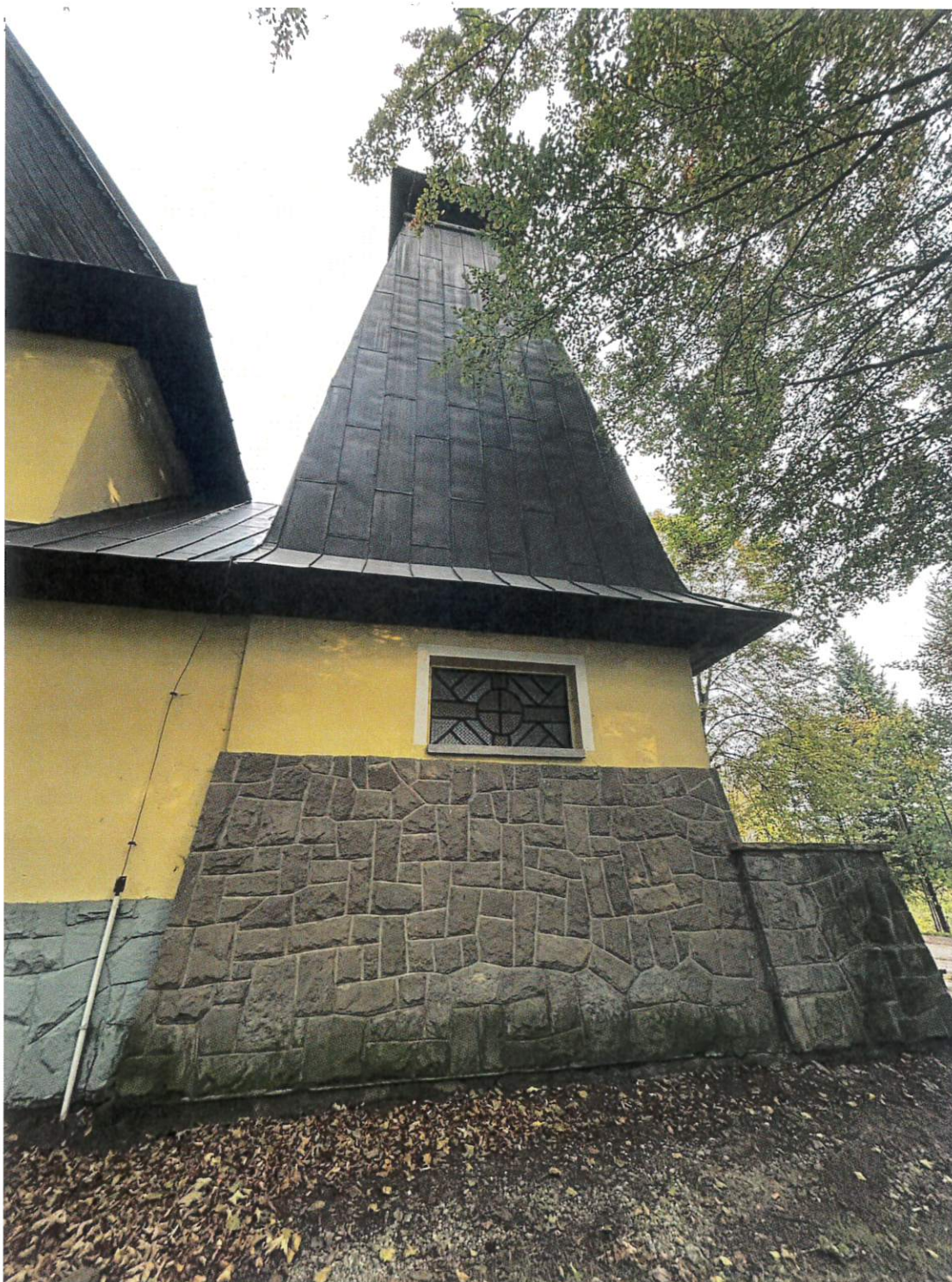
Fot. nr 8 Kaplica Matki Boskiej Szkaplerznej w Kamesznicy, dzwonnica; cokół kamienny zabrudzony, pokryty patyną, objęty korozją biologiczną.
