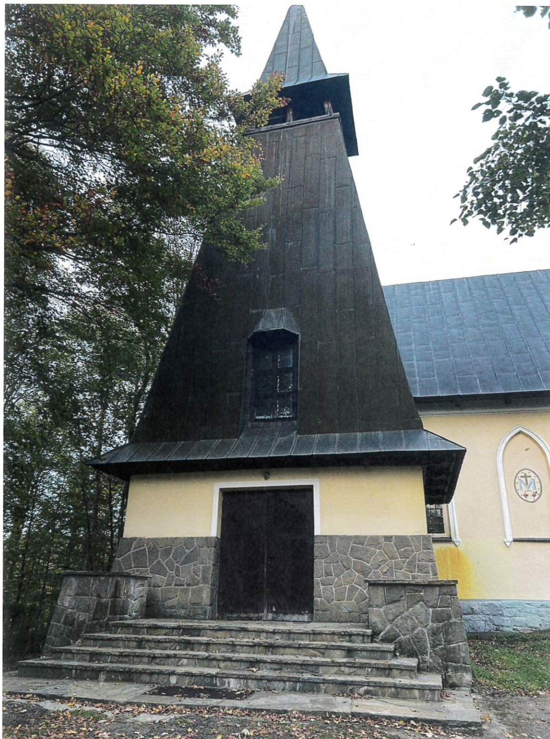
Fot. nr 1 Kaplica Matki Boskiej Szkaplerznej w Kamesznicy, dzwonnica. Widoczny pokryty czarną patyną kamień i naprawy cementowe spoin.
