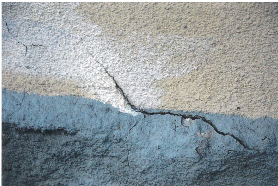
Fot. nr 13 Fot. nr 14 Kaplica Matki Boskiej Szkaplerznej w Kamesznicy. Widoczny zły stan tynków spowodowany zawilgoceniem i wadliwą technologią wykonania. Widoczne pęknięcia muru i kamieni cokołu.
