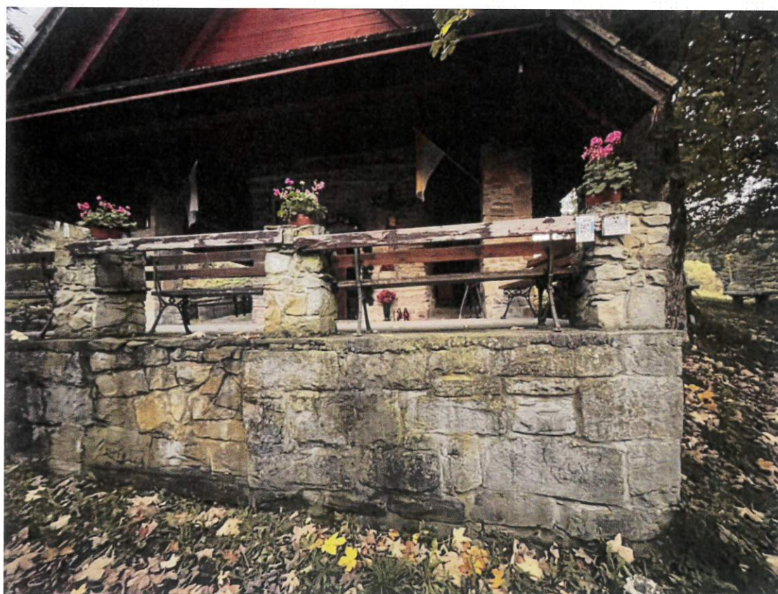
Fot. nr 7 Fot. nr 8 Kaplica Narodzenia Najświętszej Maryi Panny „Na Tarlicznym”, w Lalikach (1826 r.), strona zachodnia. Widoczny kamień z objawami korozji biologicznej.
