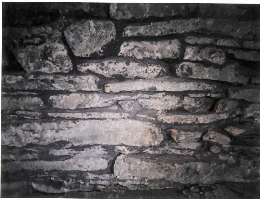
Fot. nr 11 Fot. nr 12 Kaplica Narodzenia Najświętszej Maryi Panny „Na Tarlicznym”, w Lalikach (1826 r.), strona południowa. Widoczny kamień zabrudzony powierzchniowo, z lekkimi objawami korozji biologicznej oraz spoinowaniem cementowym oraz zbutwiałe, pokryte porostami i mchem pokrycie gontowe.
