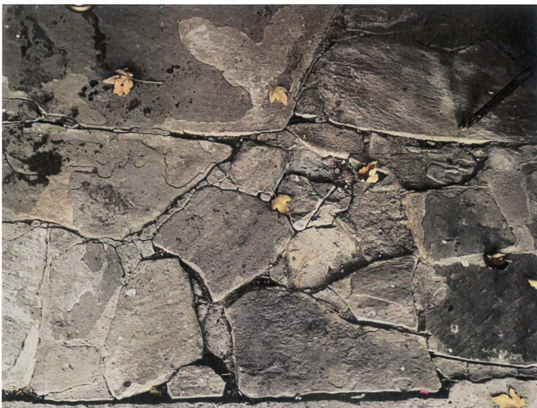
Fot. nr 17 Fot. nr 18 Kaplica Narodzenia Najświętszej Maryi Panny „Na Tarlicznym”, w Lalikach (1826 r.), fragment posadzki kamiennej ułożonej wokół kaplicy. Widoczne liczne spękania i wykruszenie spoin cementowych.
