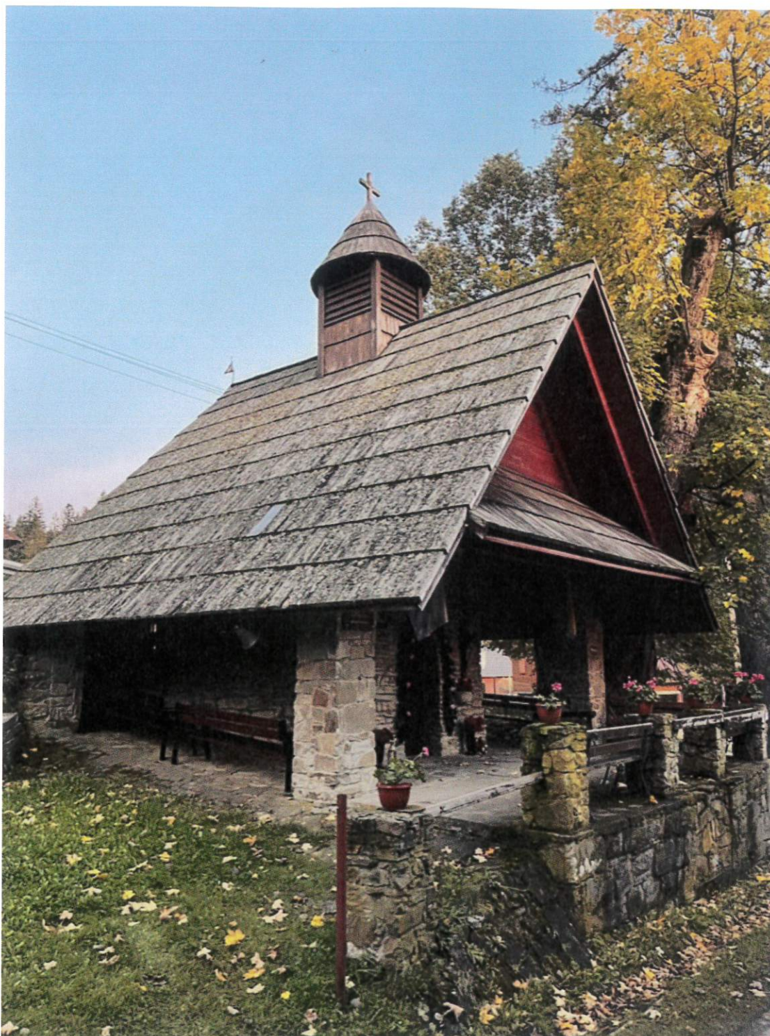
Fot. nr 6 Kaplica Narodzenia Najświętszej Maryi Panny „Na Tarlicznym”, w Lalikach (1826 r.), strona północno - zachodnia. Widoczny kamień z objawami korozji biologicznej oraz zbutwiałe, pokryte porostami i mchem pokrycie gontowe.
