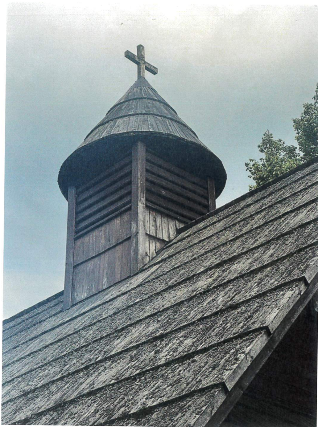
Fot. nr 22 Kaplica Narodzenia Najświętszej Maryi Panny „Na Tarlicznym”, w Lalikach (1826 r.), drewniana wieżyczka na sygnaturkę. Widoczny zły stan pokrycia gontowego.
