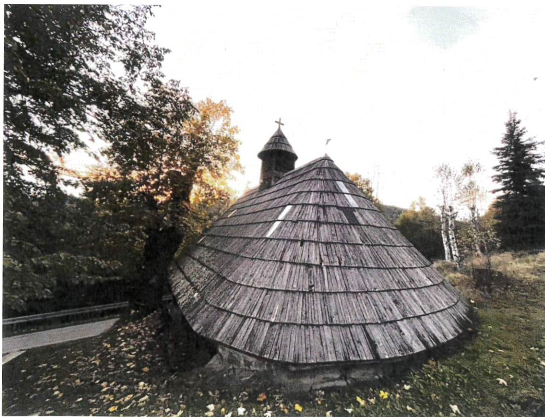
Fot. nr 23 Fot. nr 24 Kaplica Narodzenia Najświętszej Maryi Panny „Na Tarlicznym”, w Lalikach (1826 r.), strona wschodnia. Widoczny zły stan pokrycia gontowego – gont zbutwiały, objęty inwazją porostów i mchów, z licznymi ubytkami i miejscowymi naprawami z blachy i papy.
