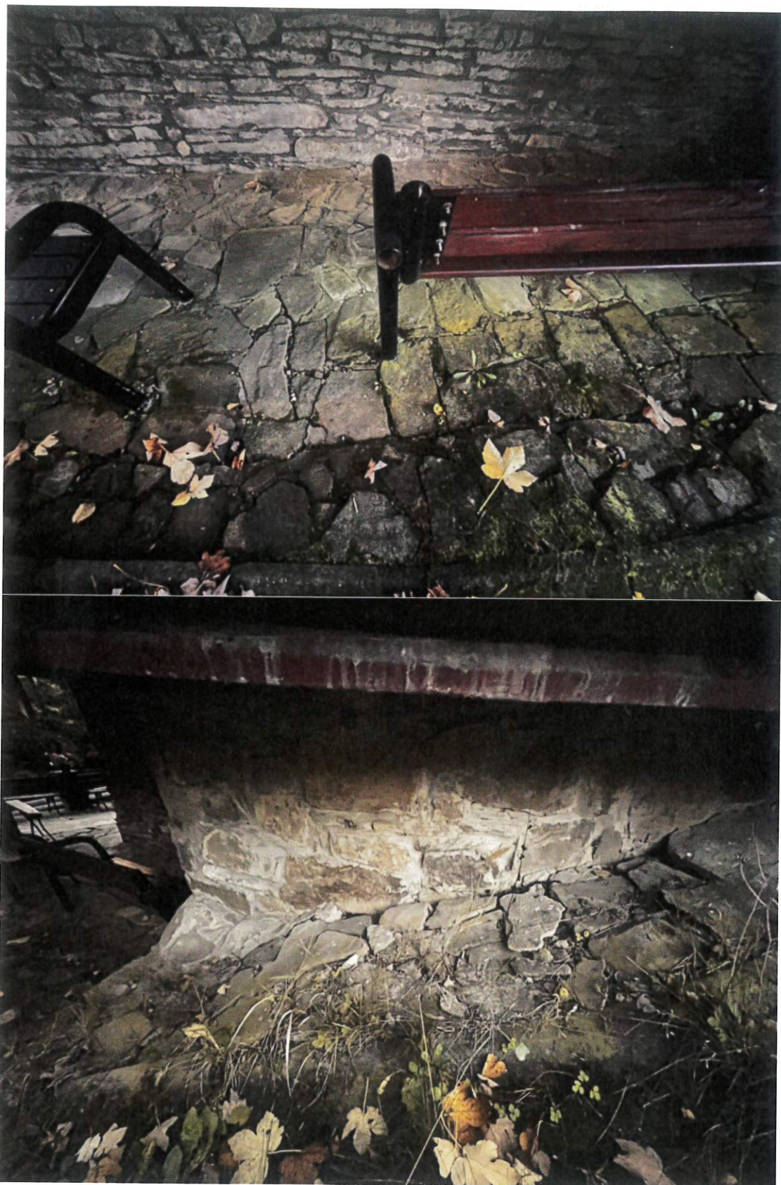
Fot. nr 19 Fot. nr 20 Kaplica Narodzenia Najświętszej Maryi Panny „Na Tarlicznym”, w Lalikach (1826 r.), fragment posadzki kamiennej ułożonej wokół kaplicy; strona południowa. Widoczne liczne spękania i wykruszenie spoin cementowych oraz zaawansowana korozja biologiczna kamienia.
