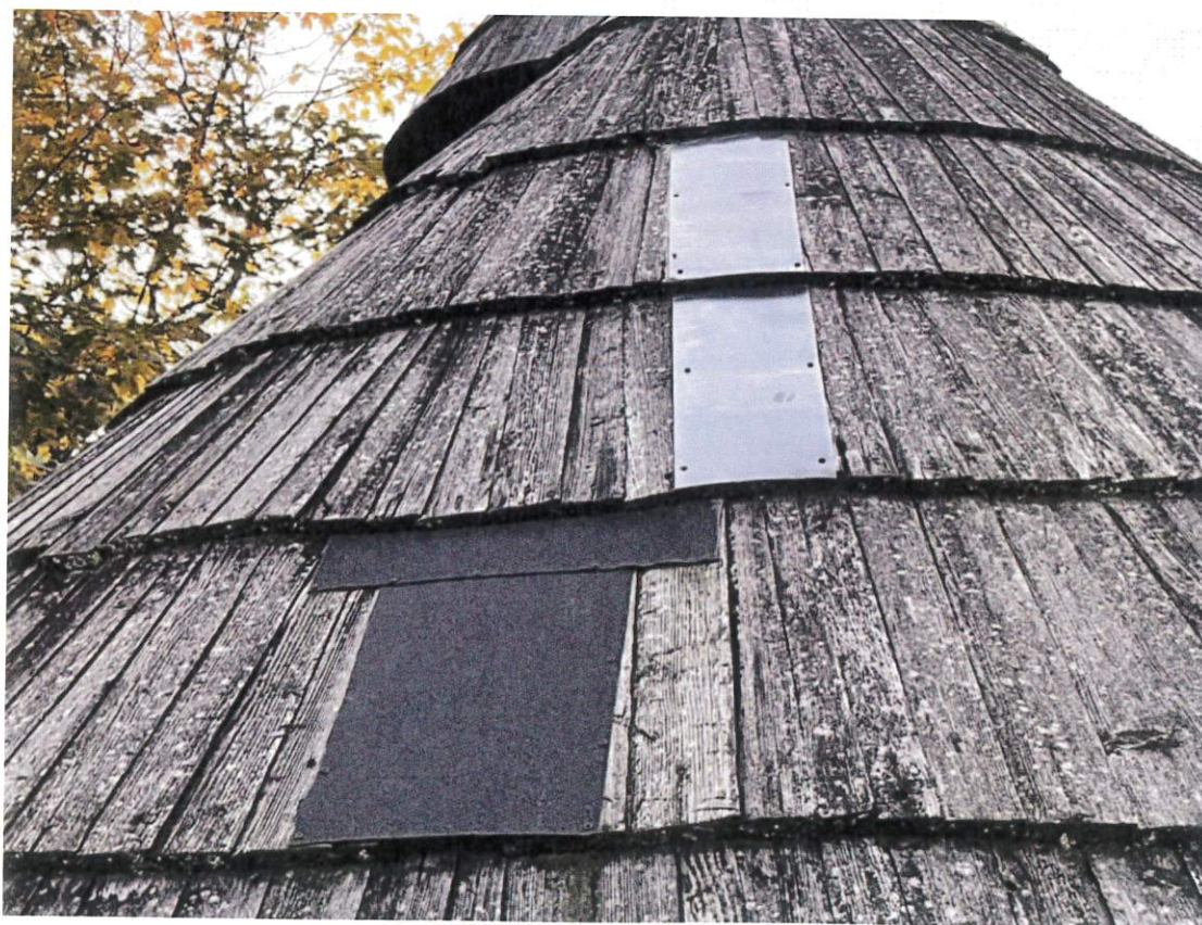
Fot. nr 25 Fot. nr 26 Kaplica Narodzenia Najświętszej Maryi Panny „Na Tarlicznym”, w Lalikach (1826 r.), strona wschodnia. Widoczny zły stan pokrycia gontowego – gont zbutwiały, objęty inwazją porostów i mchów, z licznymi ubytkami i miejscowymi naprawami z blachy i papy.
