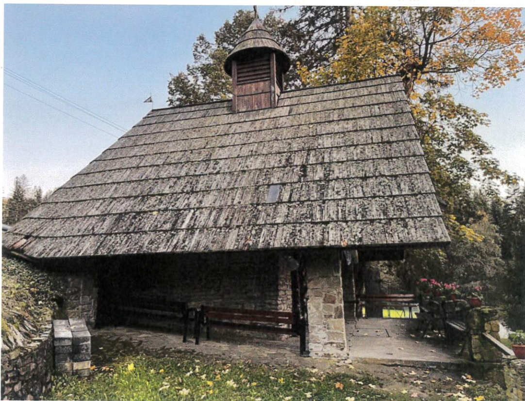
Fot. nr 4 Kaplica Narodzenia Najświętszej Maryi Panny „Na Tarlicznym”, w Lalikach (1826 r.), strona północno - zachodnia. Widoczny kamień z objawami korozji biologicznej oraz zbutwiałe, pokryte porostami i mchem pokrycie gontowe. Fot. nr 5 Kaplica Narodzenia Najświętszej Maryi Panny „Na Tarlicznym”, w Lalikach (1826 r.), strona północna.
