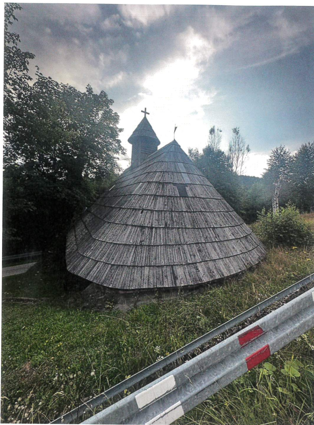
Fot. nr 21 Kaplica Narodzenia Najświętszej Maryi Panny „Na Tarlicznym”, w Lalikach (1826 r.), strona wschodnia. Widoczny zły stan pokrycia gontowego.
