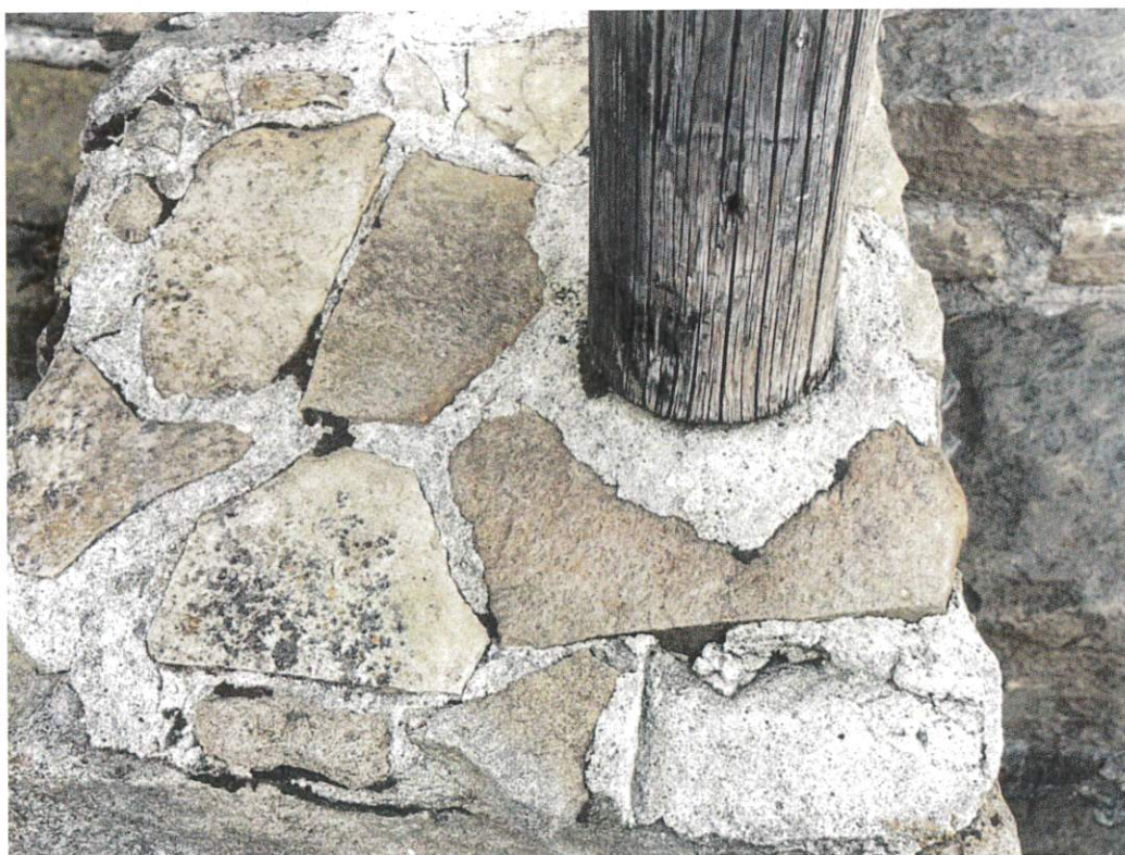
Fot. nr 16 17 Kościół Najświętszej Marii Panny Nieustającej Pomocy w Lalikach, widoczny zszarzały, wyjąłowany szalunek, wymyty w strefie cokołowej przez odbijającą się od podłoża wodę opadową. Fot. nr 18 Kościół Najświętszej Marii Panny Nieustającej Pomocy w Lalikach. Widoczne zabrudzenie i uszkodzenia kamienia, wykruszone i spękane spoiny cementowe, rozeschnięte, spękane wzdłużnie elementy konstrukcyjne podtrzymujące zadaszenie wejścia bocznego od strony pd. – zach.
