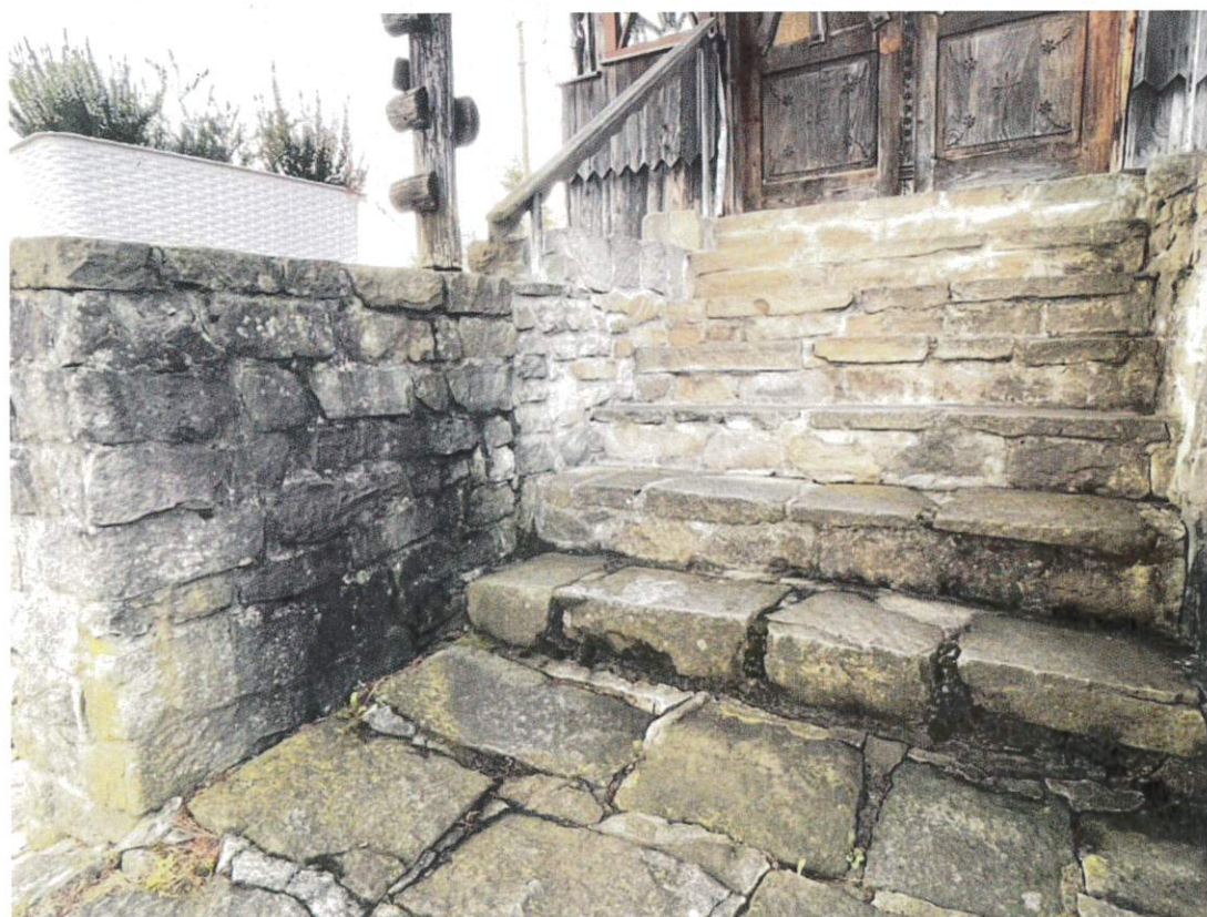
Fot. nr 11 Fot. nr 12 Kościół Najświętszej Marii Panny Nieustającej Pomocy w Lalikach, elewacja pd. - zach. Widoczny zły stan zachowania cokołu kamiennego, schodów i murków. Kamień zabrudzony, z nalotem czarnej patyny, glonów i mchów. Widoczne spękane i wykruszające się spoinowanie cementowe, zachłapania cokołu.
