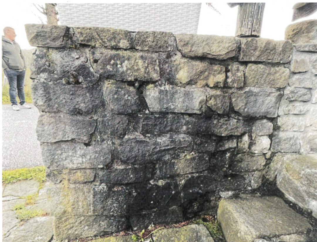
Fot. nr 19 20 Kościół Najświętszej Marii Panny Nieustającej Pomocy w Lalikach, fragmenty kamiennego cokołu. Widoczne fugi cementowe, zabrudzenie, zachłapanie cokołu.
