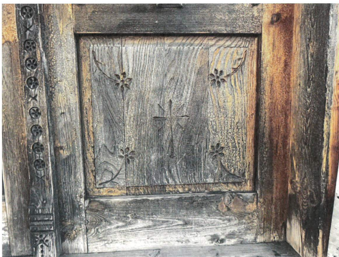
Fot. nr 13 Fot. nr 14 Kościół Najświętszej Marii Panny Nieustającej Pomocy w Lalikach, strona pn. - wsch., wejście główne. Widoczne przetarcia i złuszczenia warstw zabezpieczających drzwi drewniane, wyjąłowanie i zszarzenie drewna.
