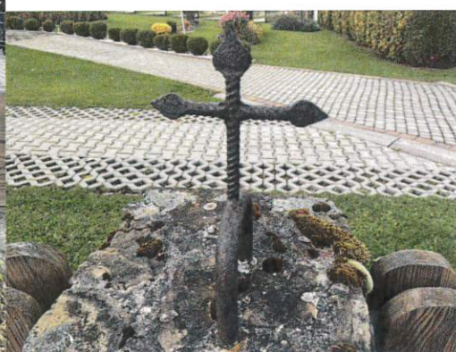
Fot. nr 32 Fot. nr 33 Fot. nr 34 Fot. nr 35 36 Kościół Najświętszej Marii Panny Nieustającej Pomocy w Lalikach, ogrodzenie wokół kościoła., fragmenty. Widoczny nalot czarnej patyny, korozja biologiczna kamienia, wykruszenia cementowego spoinowania, metalowe krzyże spatinowane i objęte korozją.
