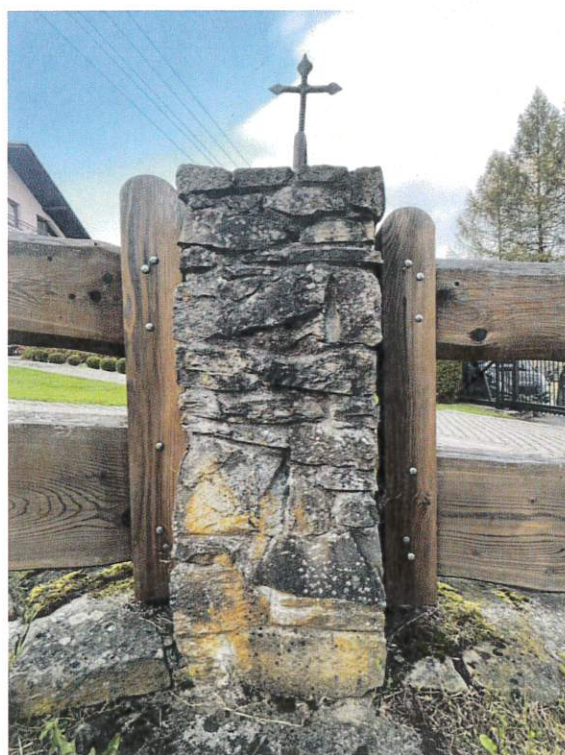
Fot. nr 32 Fot. nr 33 Fot. nr 34 Fot. nr 35 36 Kościół Najświętszej Marii Panny Nieustającej Pomocy w Lalikach, ogrodzenie wokół kościoła., fragmenty. Widoczny nalot czarnej patyny, korozja biologiczna kamienia, wykruszenia cementowego spoinowania, metalowe krzyże spatinowane i objęte korozją.
