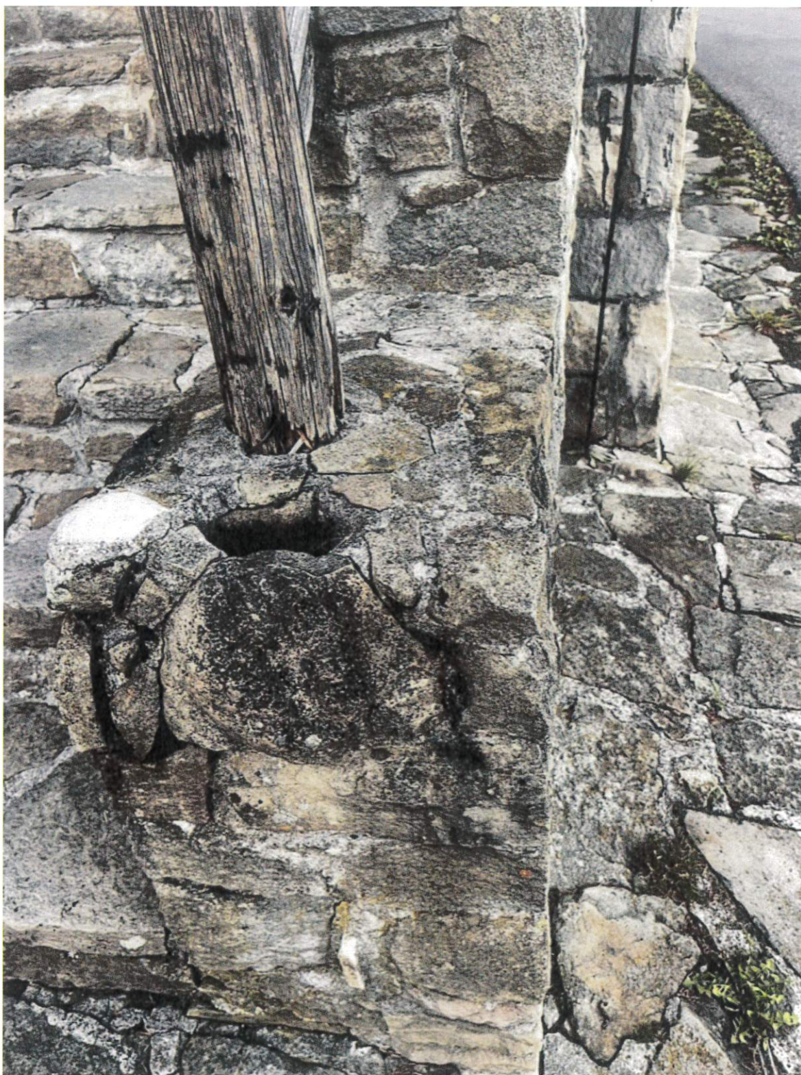
Fot. nr 23 24 Kościół Najświętszej Marii Panny Nieustającej Pomocy w Lalikach, fragment murków przy wejściu głównym do kościoła. Widoczna degradacja kamienia, ubytki, pęknięcia kamienia spowodowane przemrożeniem, nalot czarnej patyny, rozległa korozja biologiczna, rozeschnięte elementy drewniane podtrzymujące zadaszenie.
