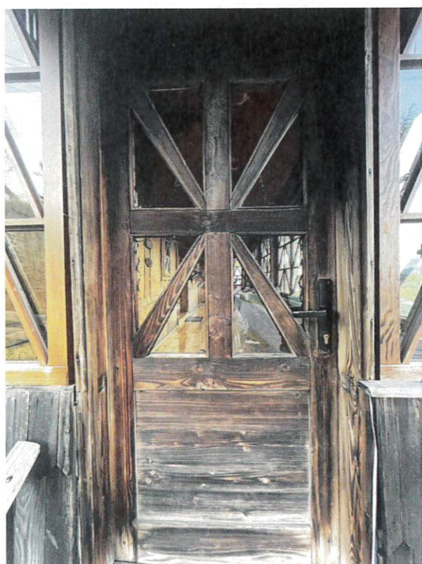
Fot. nr 8 Kościół Najświętszej Marii Panny Nieustającej Pomocy w Lalikach, elewacja pd. – zach. Fot. nr 9 Kościół Najświętszej Marii Panny Nieustającej Pomocy w Lalikach, elewacja pd. – zach., stolarka drzwiowa. Widoczne zciemniałe, przetarte drewno.
