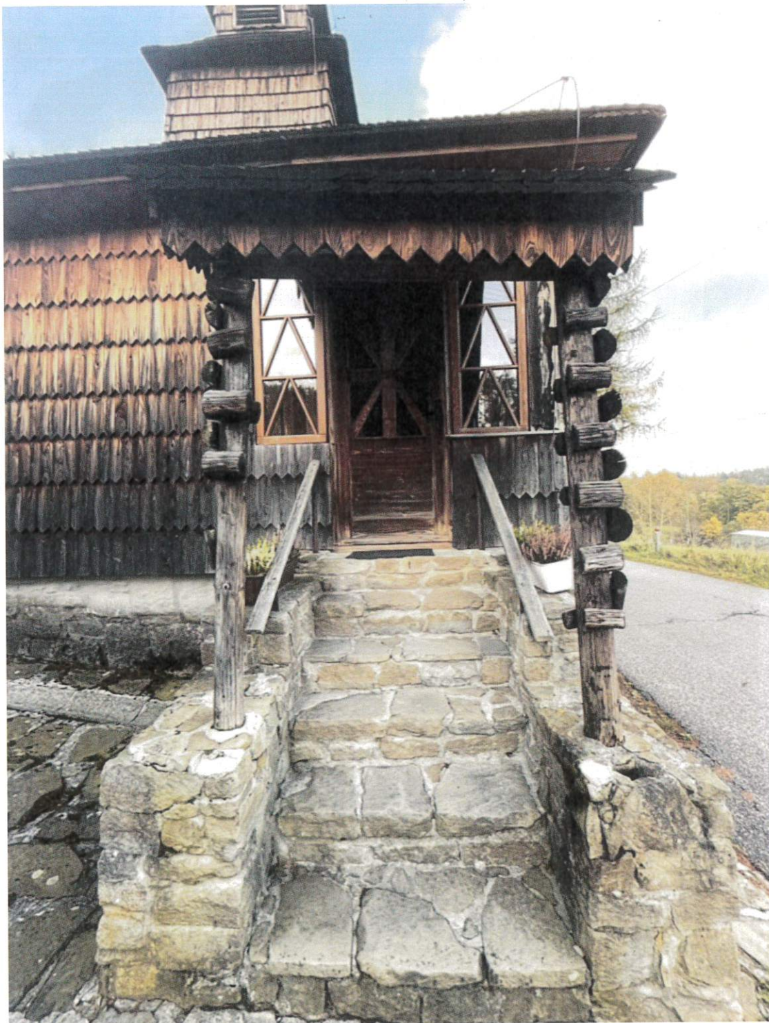
Fot. nr 10 Kościół Najświętszej Marii Panny Nieustającej Pomocy w Lalikach, strona pd. – zach. Schody i murki z ciosów piaskowca. Widoczne zabrudzenie i uszkodzenia kamienia, wykruszone i spękanе spoiny cementowe.
