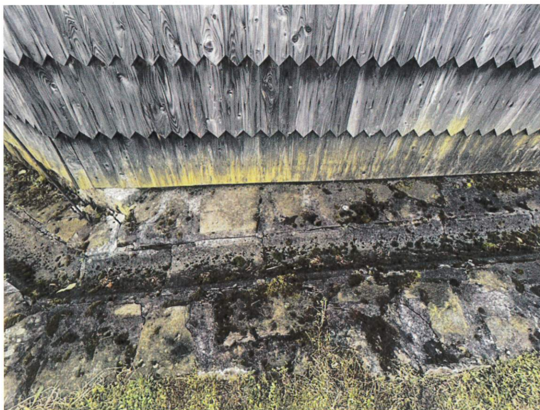
Fot. nr 25 Fot. nr 26 27 Kościół Najświętszej Marii Panny Nieustającej Pomocy w Lalikach, cokół kamienny i opaska z odwodnieniem wokół kościoła. Widoczny nalot glonów w strefie cokołowej, wymycie dolnych partii elewacji spowodowane odbijaniem się wody opadowej; inwazja mchów i porostów w obrębie opaski kamiennej.
