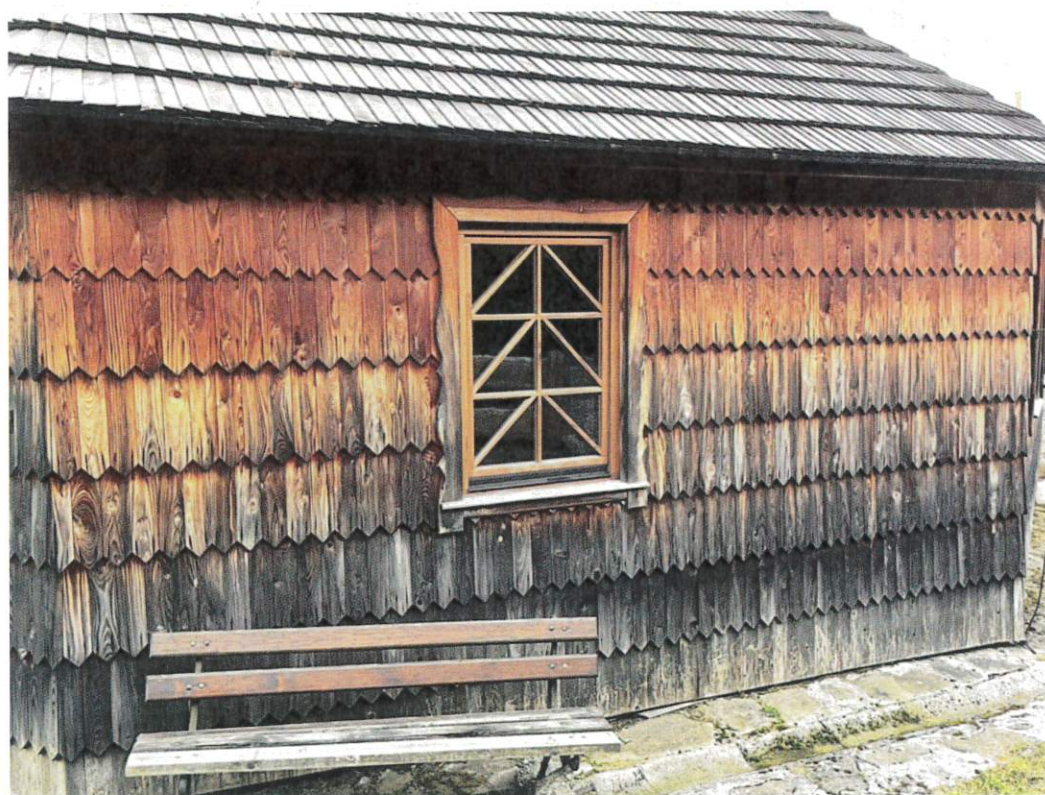
Fot. nr 6 Fot. nr 7 Kościół Najświętszej Marii Panny Nieustającej Pomocy w Lalikach, elewacje pn. – zach. Widoczny zszarzały szalunek gontowy z objawami korozji biologicznej w partii cokołowej.
